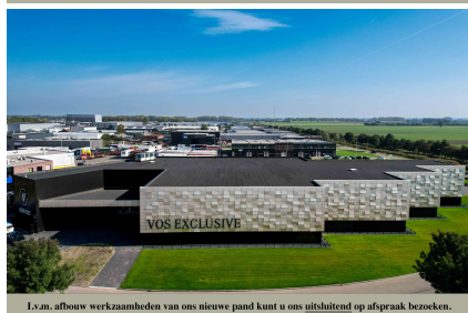
I.v.m. afbouw werkzaamheden van ons nieuwe pand kunt u ons uitsluitend op afspraak bezoeken.
